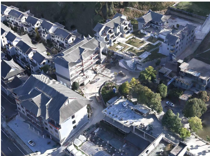
项目现状实景图
