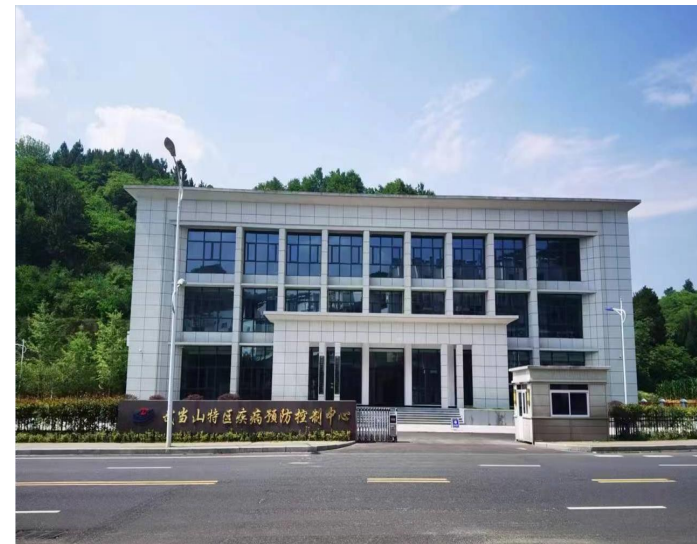
项目竣工后现状
